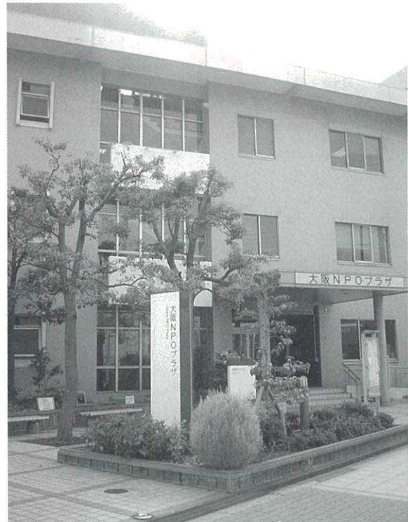
大阪NPOプラザ外観
